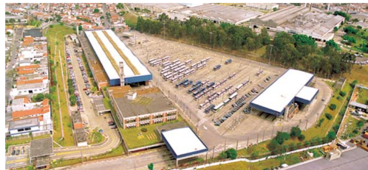
SEDE DA EMTU/SP - LOCAL ONDE SERÁ IMPLANTADA A UNIDADE DE PRODUÇÃO E ABASTECIMENTO DE HIDROGÊNIO DO PROJETO Fonte: EMTU/SP - 2009.
